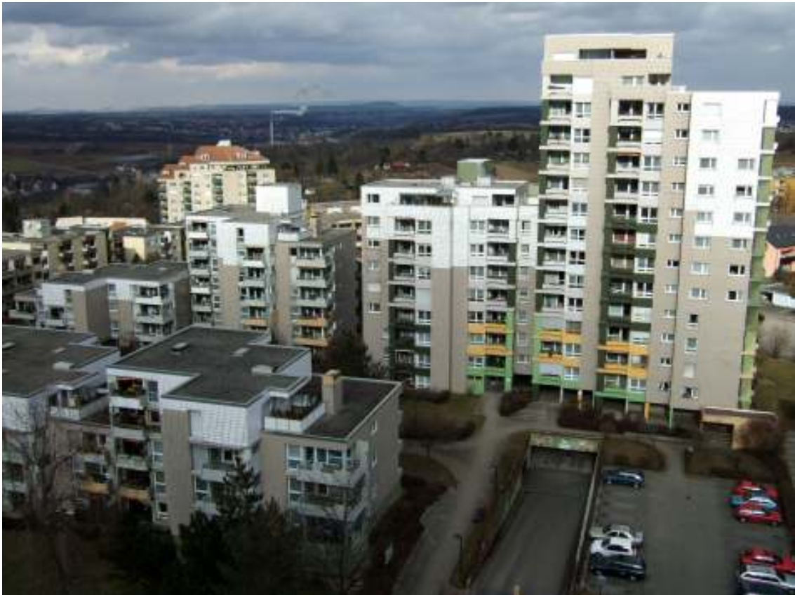
Abbildung 16: Wohnkomplexe in Stuttgart-Neugereut
